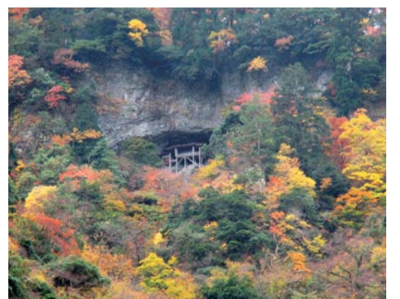
三徳山投入堂は断崖絶壁の神窟（パワースポット）
